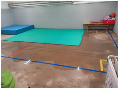
der ganze Keller unter Wasser ....
